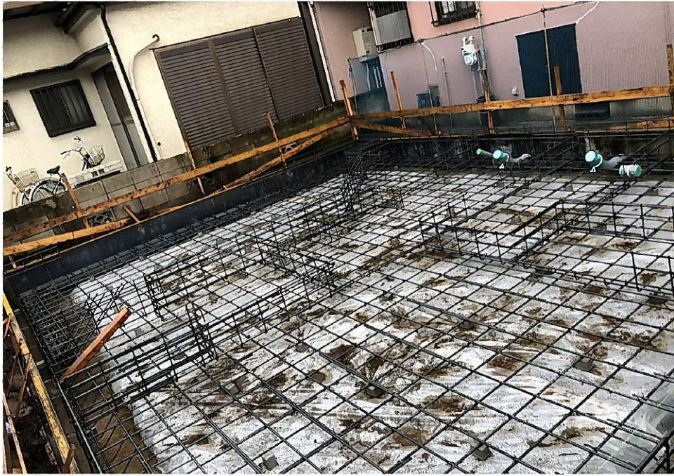
2020. 7. 9配筋検査 (株)シンセイハウジング様 (埼玉県新座市栄/3F)
