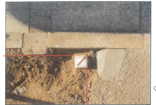
点S4：新設コンクリート杭
