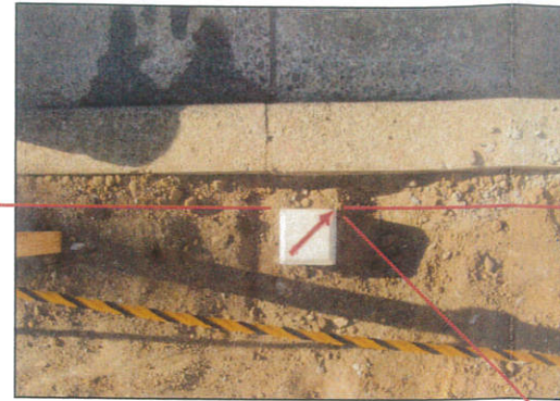
点S2：新設コンクリート杭
